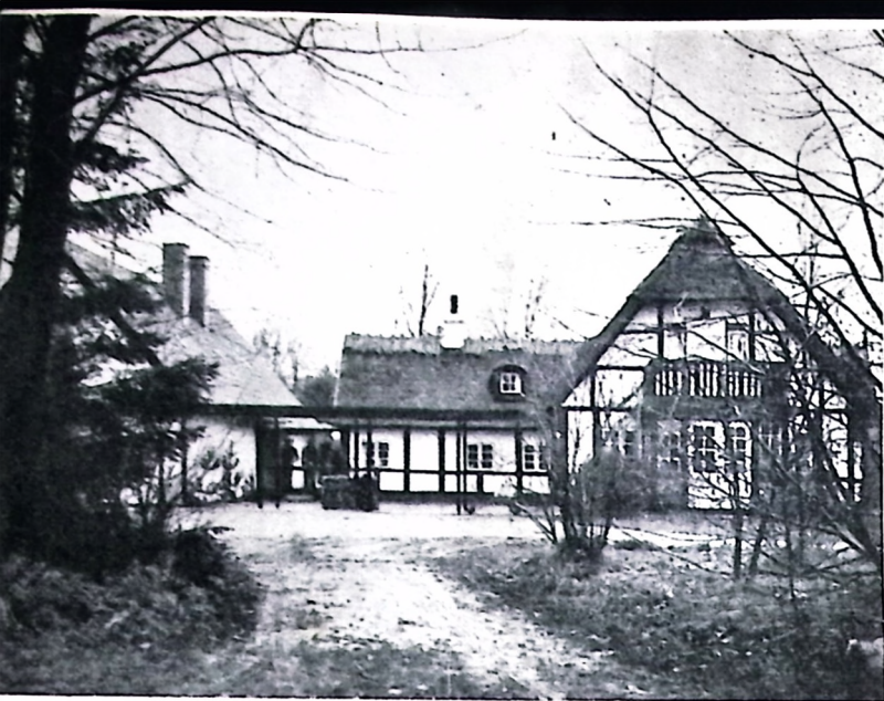
Jægergården set fra syd; østflojen er den oprindelige gård, nybygningen ses til venstre
