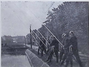
Dampsprøjteprøve paa Vandværkets Filterplads.
