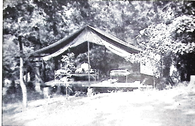
Teltet er hævet ved et trægulv ca. 1 m p. gr. af slangeføren
