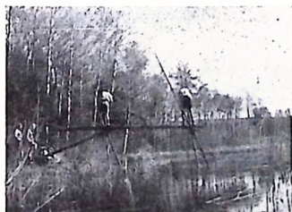
Den anden buk på plads. Broen blev 20 m lang!
