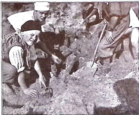
Udgravning af Pæleværket
