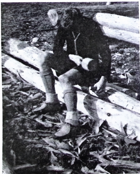
Fra landsskovmandslutneringen — bygning af TOMAHAWK-SHELTER
