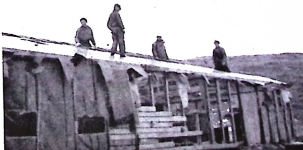
Store spejdere på nedrivningsarbejde
